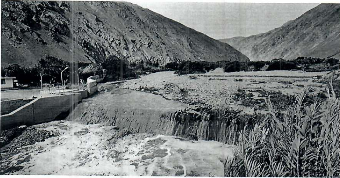
Captación Bocatoma "El Canuto"
