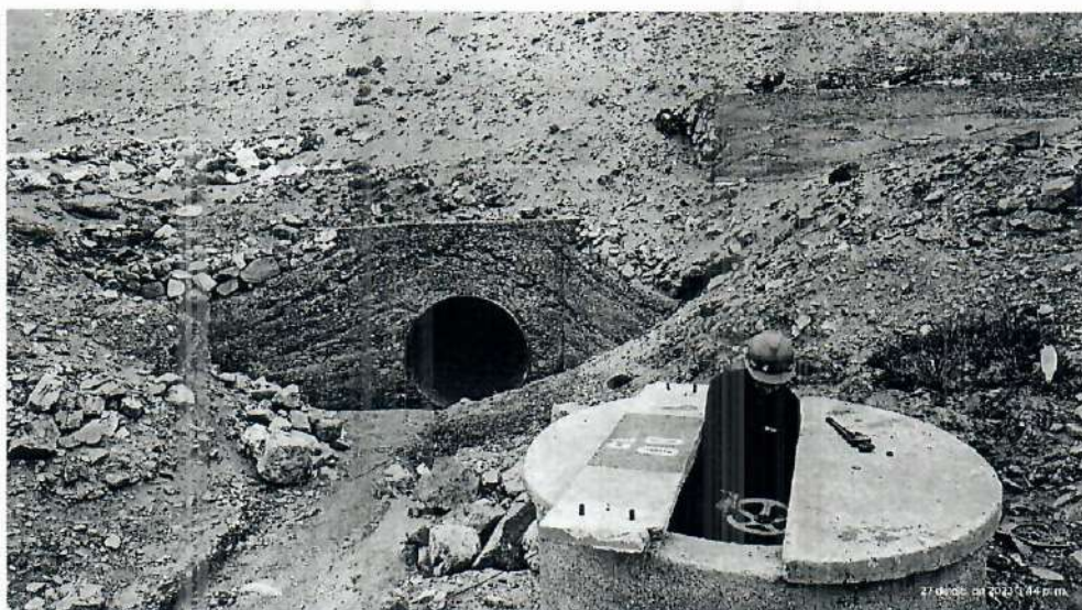
Mantenimiento de válvula de lodos en línea de conducción de ITE
