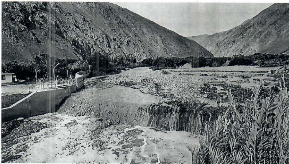
Captación Bocatoma "El Canuto"
