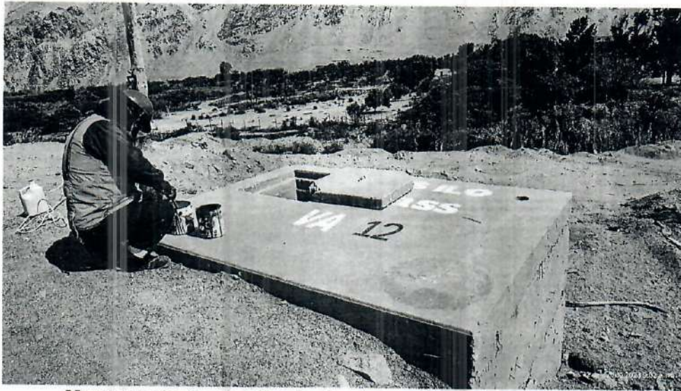
Mantenimiento de válvula de aire en línea de conducción.
